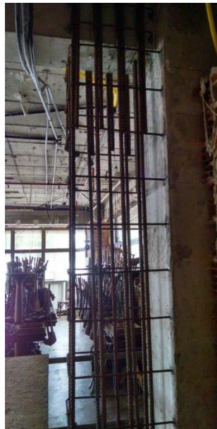
Figura 11.a e Figura 11.b – Inseção do pilar metalico na cozinha do restaurante .
