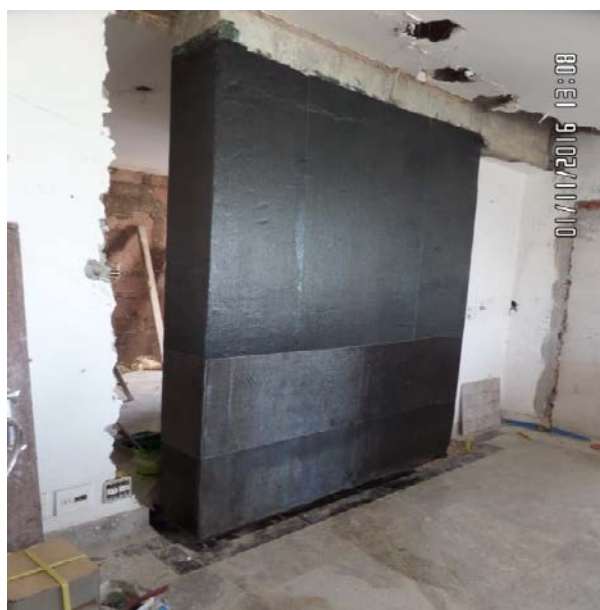
Figura 19 – Início da aplicação da segunda camada de fibra.
