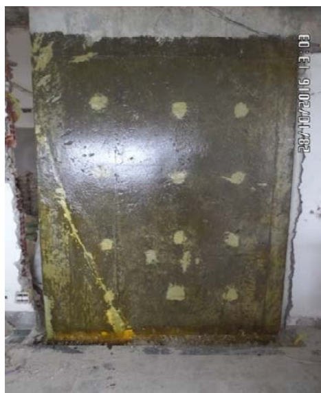
Figura 17 – Pilar com as duas camadas de epóxi aplicadas.
