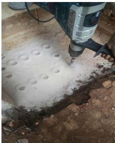
Figura 9.a e Figura 9.b – Marcação da furação e armadura de arraque do reforço .
