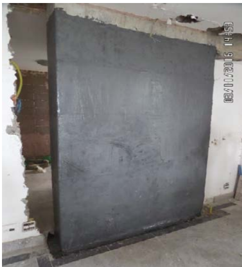
Figura 20 – Peças com camada final de acabamento epoxico.
