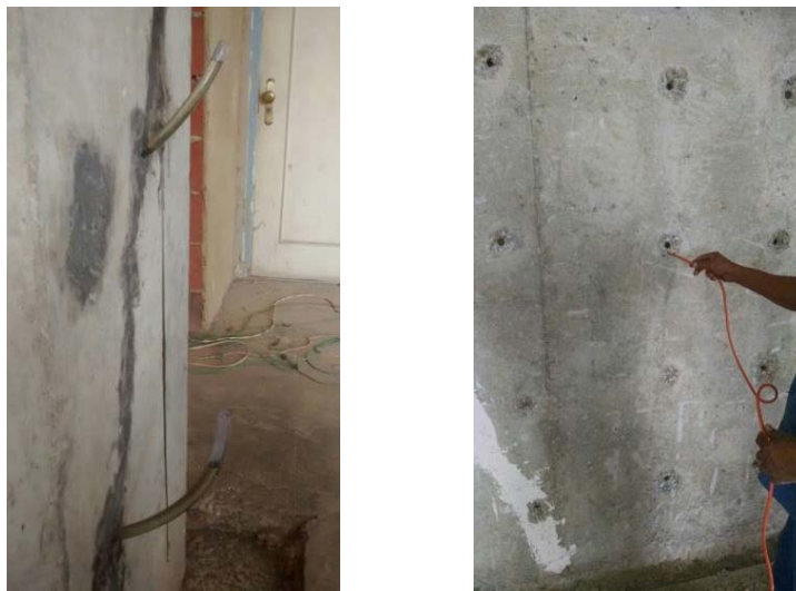
Figura 16.a e Figura 16.b – Aplicação de resina e aspensão das superfícies..
