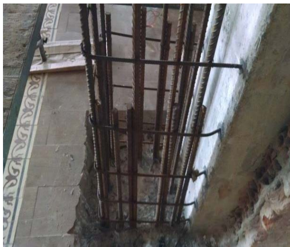
Figura 9.a e Figura 9.b – Marcação da furação e armadura de arraque do reforço .
