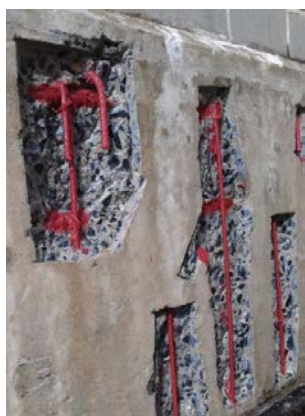
Figura 08: Proteção da armadura executada através de pintura com primer a base de zinco.
