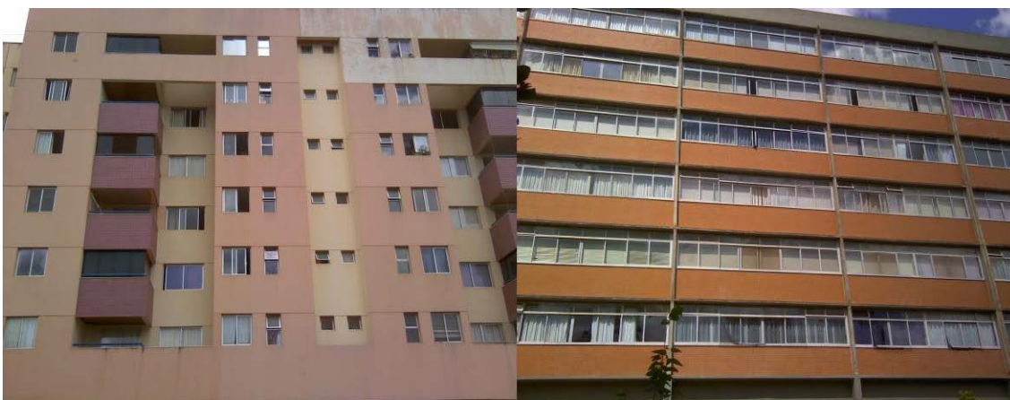
Figura 1: Fachadas inspecionadas revestimento em argamassa e placas cerâmicas, respectivamente.
