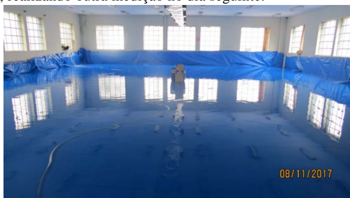
Figura 9 – Ala Norte – Ensaio na laje.
