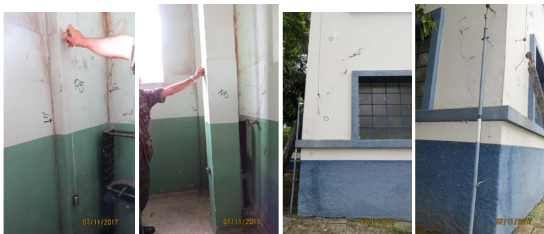
Figura 5 – Ala Sul – Vistoria no 1º pavimento para ensaio no Pilar P5. Fissuras a 45° nas alvenarias, afundamentos no piso e pilares apurados.
