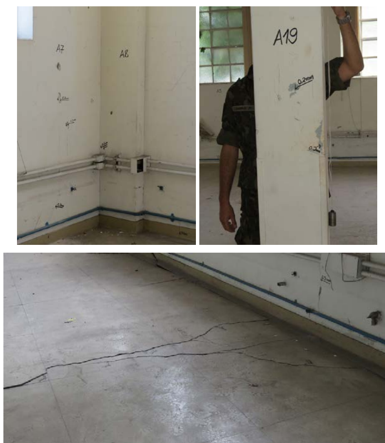
Figura 5 – Ala Sul – Vistoria no 1º pavimento para ensaio no Pilar P5. Fissuras a 45° nas alvenarias, afundamentos no piso e pilares apurados.
