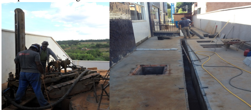
Figura 7: Execução das microestacas e vista do local após a obra de reparo – Fonte: os autores
