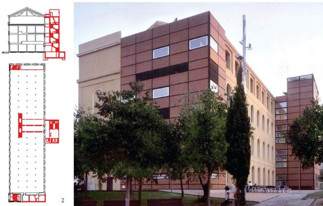
Fig. 4.: Fábrica Can Fabra. Nuevo acceso vertical por el exterior de la nave
