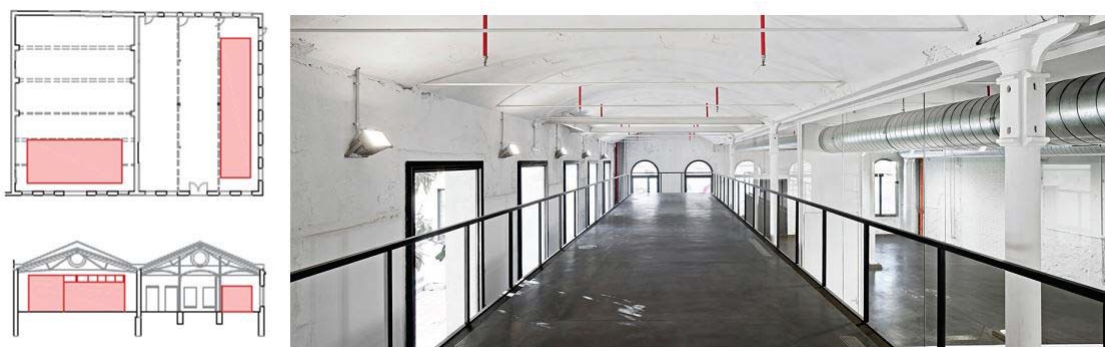
Fig. 2.: Fábrica Can Ricard: Disposición de nuevos altillos en el interior de las naves
