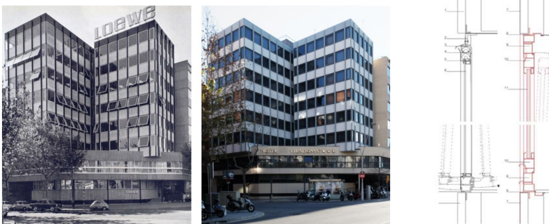
Fig. 4.: Edificio Loewe: Aspecto anterior y posterior a la intervención integral
