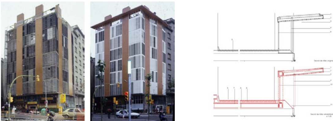
Fig. 7.: Barceloneta. Antes y después de la reconstrucción del alero y la sustitución de las celosías
