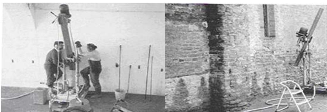
Figura 2: Técnicas de execução com equipamento de perfuração de grande porte. Fonte: TORSELLO B. P. – MUSSO S.F. (2010)
