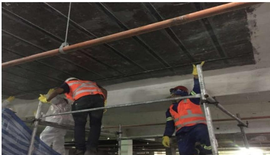
Figura 03 – Colocação da fibra de carbono
