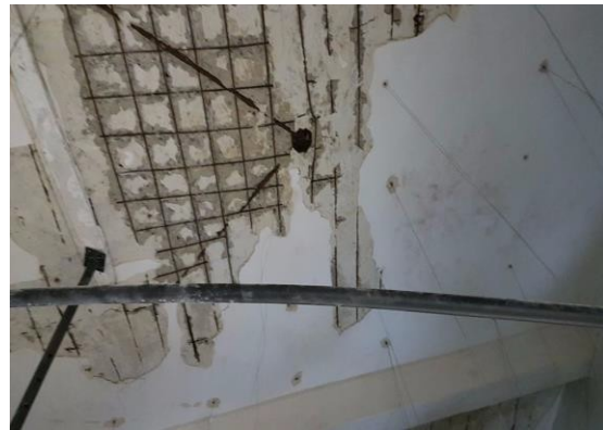
FIGURA 3: Foco do estudo, anexo do Bloco 5 (Consultórios). FONTE: Autores.
