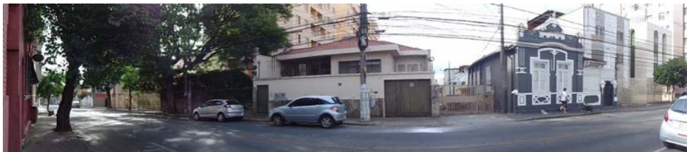
Figura 02: Foto panorâmica Rua Hermilo Alves – Casa da Vila, nº 275. Fonte: Acervo próprio
