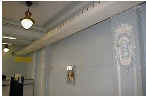
Figuras 11 e 12: Dutos de ar condicionado interceptando esquadria da fachada frontal e no andar superior, duto interceptando os ornatos existentes nos pilares. Fonte: Foto do autor. 2016.
