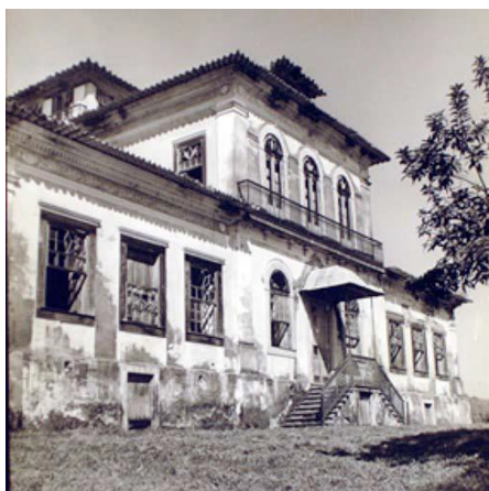
Figura 5 – Fachada. Década de 50. Fonte: Acervo Arquivo Central IPHAN-RJ, 2017.
