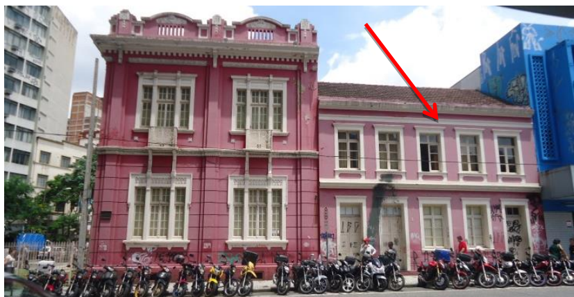
Figura 03: Edifício 2 – Contíguo ao Edifício 1 Fonte: O Autor, 2017
