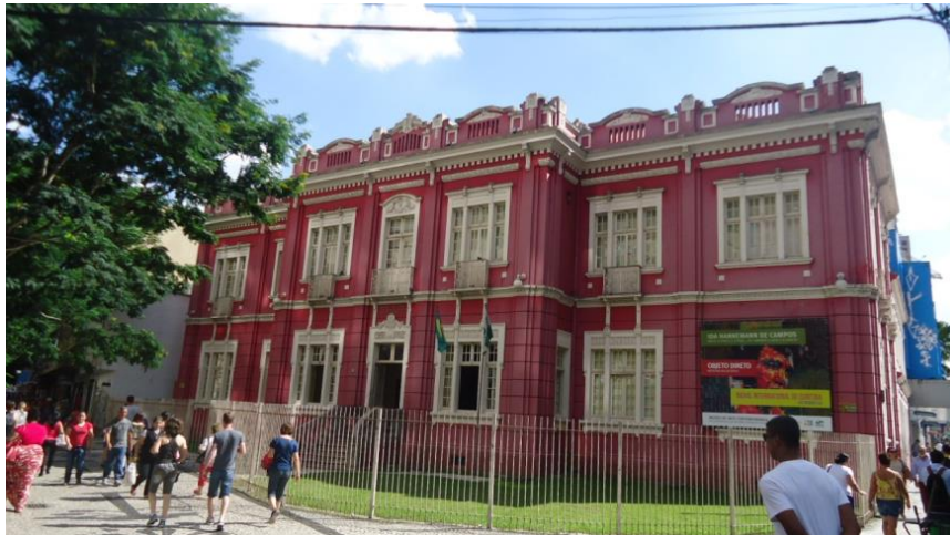
Figura 02: Vista frontal do edifício 1 Fonte: O Autor, 2017
