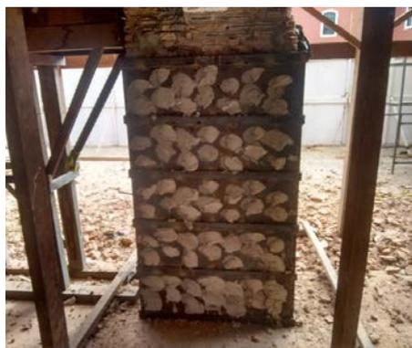
Figura 11: Injeções de calda de cal hidratada (Fonte: Arquivos IPHAN).
