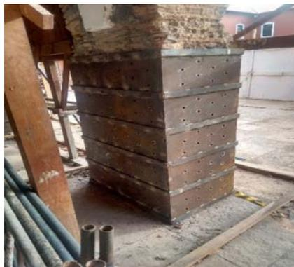
Figura 10: Placas metálicas com furos (Fonte: Arquivos IPHAN).
