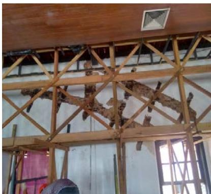
Figura 7: Grampeamento das fissuras em paredes (Fonte: Arquivos IPHAN).
