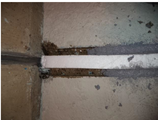
Figura 16: Aplicação de argamassa epoxídica (fonte: próprio autor)
