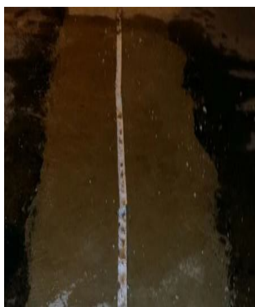
Figura 12: Cura hidráulica do graute (fonte: próprio autor)
