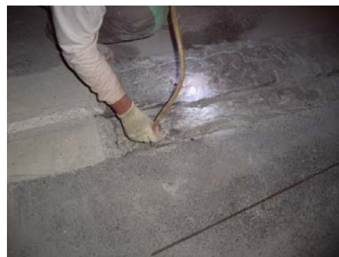
Figura 8: Compressor auxiliando na limpeza do substrato (fonte: próprio autor)
