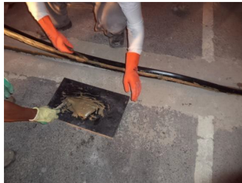
Figura 19: Aplicação de Adesivo Epóxi bicomponente (fonte: próprio autor)
