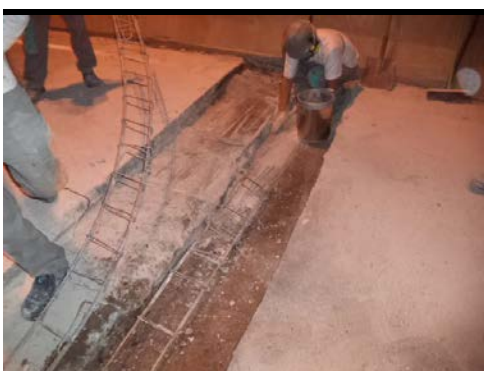
Figura 7: Retirada de armadura antiga, danificada (fonte: próprio autor)
