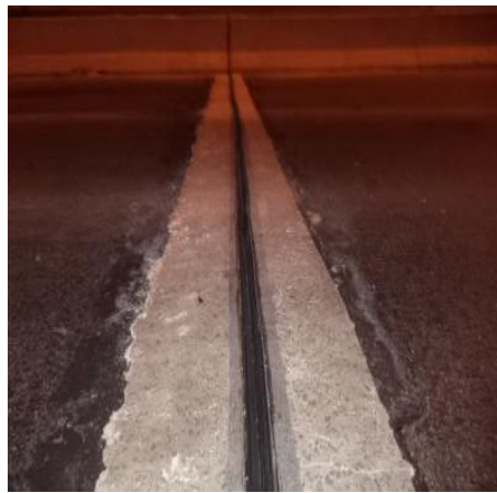
Figura 21: Junta de dilatação recuperada (fonte: próprio autor)
