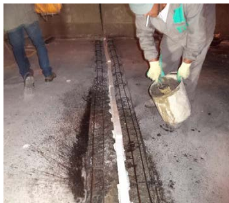
Figura 10: Isopor usado como fôrma e umedecimento de substrato (fonte: próprio autor)
