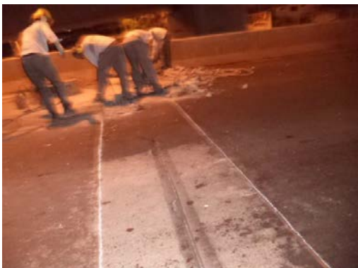
Figura 5: Área a ser demolida (fonte: próprio autor)
