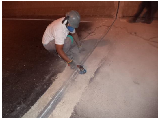
Figura 17: Lixamento da superfície do berço (fonte: próprio autor)
