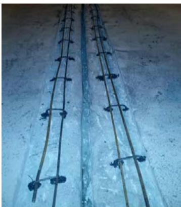
Figura 9: Armação do berço (fonte: próprio autor)
