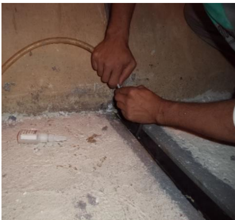
Figura 20: Pressurização do perfil elastomérico (fonte: próprio autor)
