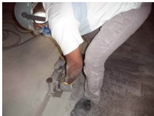
Figura 14: Berço sendo cortado para receber o lábio (fonte: próprio autor)
