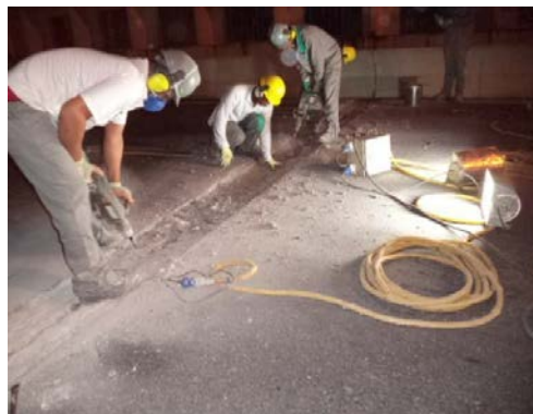
Figura 6: Demolição do berço e lábio (fonte: próprio autor)
