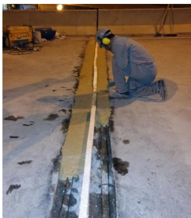
Figura 11: Aplicação de graute (fonte: próprio autor)
