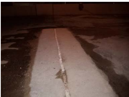
Figura 13: Berço executado (fonte: próprio autor)
