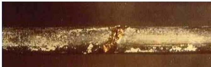
Figura 3: Ruptura típica de corrosão sob tensão: corte transversal na armadura. Fonte: Paulo Helene (25)
