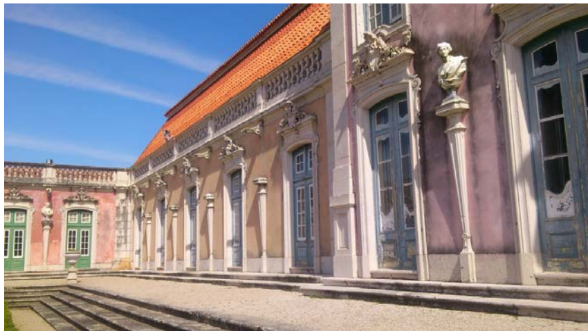
Figura 4: Multiplicidade de cores e tons das fachadas e portas, antes da intervenção (fonte: PSML)
