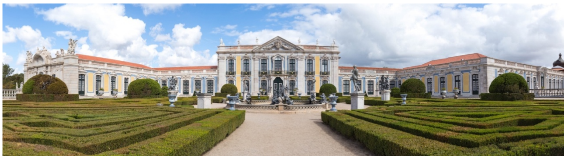
Figura 6: Fachada de Cerimónia, depois da intervenção (fonte: PSML).
