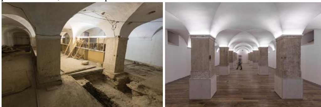
Figura 9 – Sala de eventos antes e depois da intervenção (fonte: PSML).
