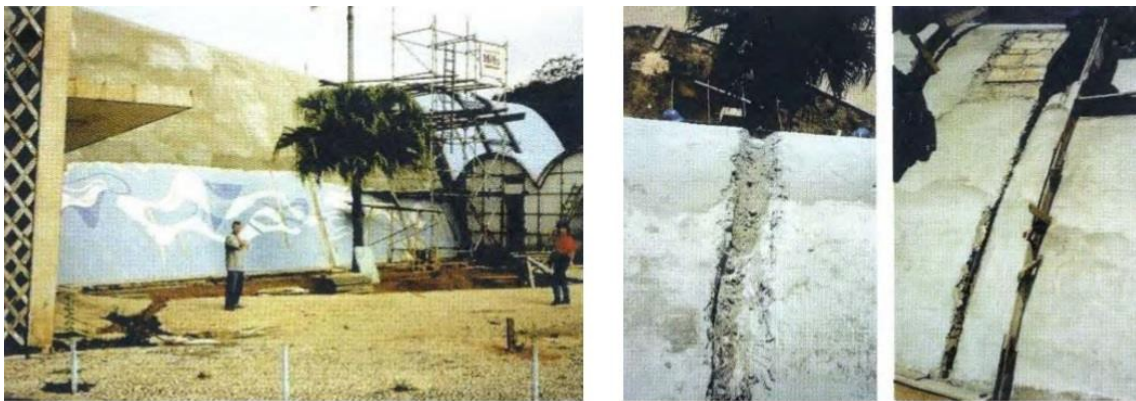
Figura 9: Retirada das pastilhas da nave central. Figuras 10 e 11: Recuperação das juntas de dilatação Fonte: CASTRO, 2006, p.21.
