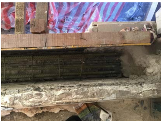
Figura 4: Ancoragem das armaduras após reforço.
