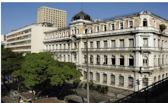
Figura 01: Fachadas originais do Palacete Dom João VI (dir.) e Terminal Rodoviário (esq.).
