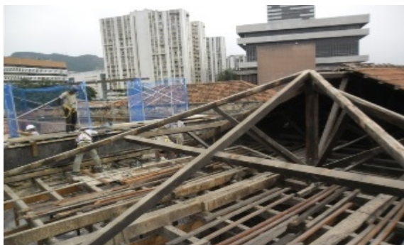
Figura 04: Demolição de varanda posterior do prédio 01. Fonte: ETU (2017) 12 .
