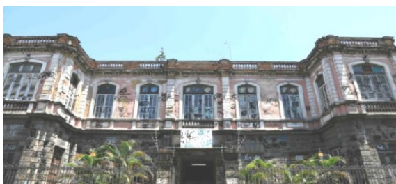
Figura 08: Situação da Fachada.
