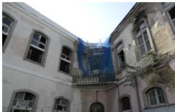
Figura 13: Recuperação dos revestimentos da varanda dos prédios 01 e 03.
