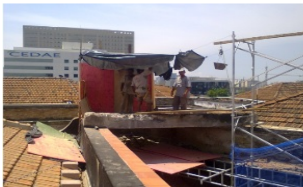
Figura 05: Demolição de estruturas da caixa d'água, a cobertura do prédio 07. Fonte: ETU (2017) 12 .
