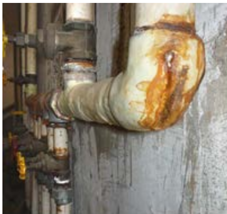
Figura 1: Detalhe do uso indiscriminado de resinas em reparos de tubulações. (Fonte: Acervo dos autores)
