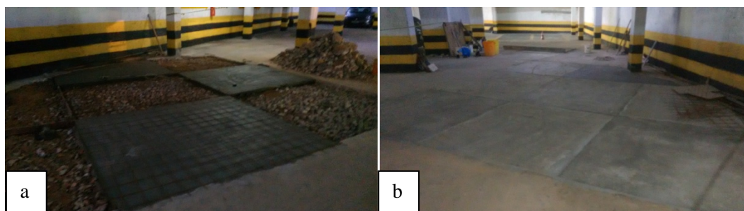
Figura 10: a. Placas da Área 2; b. Área 2 com as placas concretadas.
