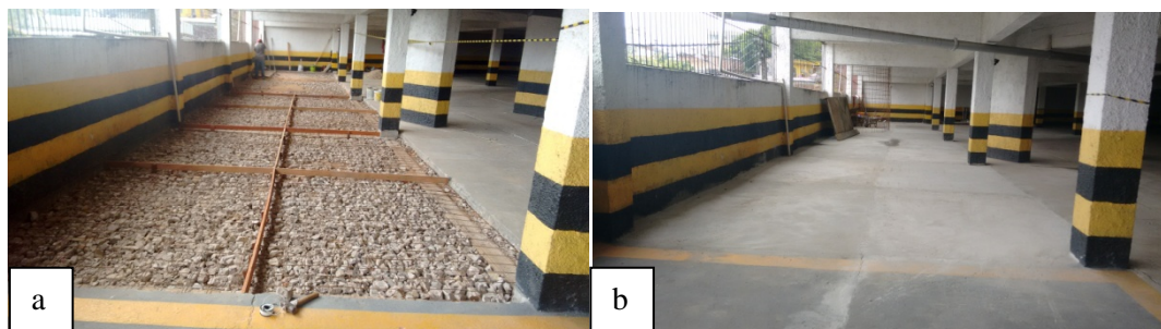
Figura 9: a. Gabarito com tela pop para as placas da Área 1; b. Área 1 com as placas concretadas.
