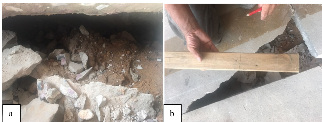
Figura 8: a. Área sob a placa; b. Altura do rebaixamento do piso.
