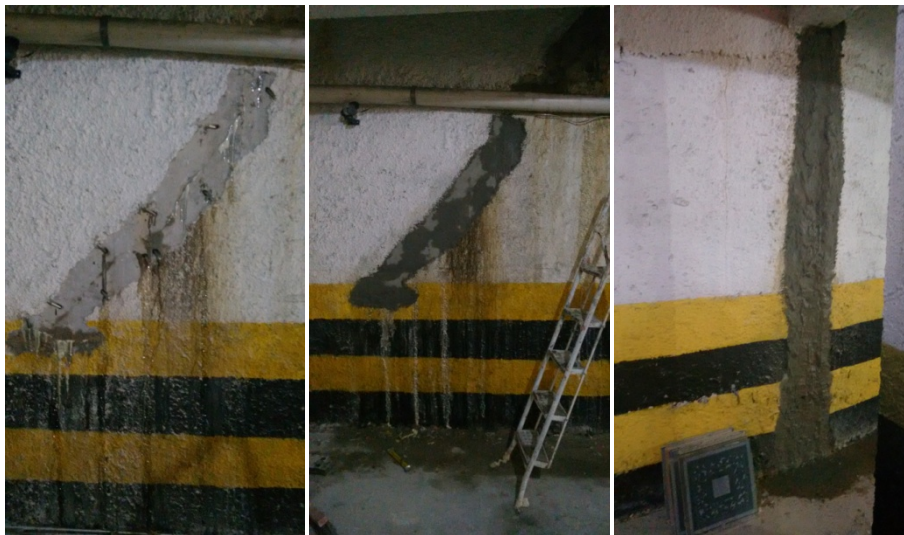
Figura 4: a. Injeção de resina por meio de pinos; b. Aplicação de argamassa impermeabilizante sob os furos; c. Aplicação da argamassa em toda a área de infiltração.
