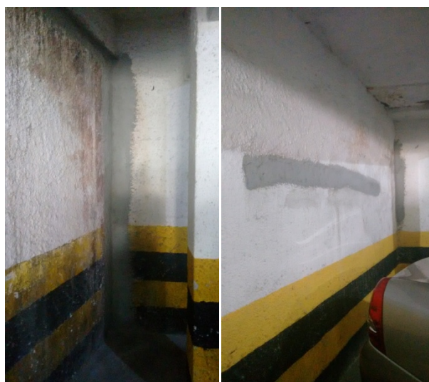
Figura 5: Apenas a aplicação da argamassa impermeabilizante em áreas de infiltração.
