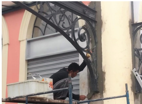
Figura 14: Aplicação de argamassa. Fonte: Acervo próprio.
