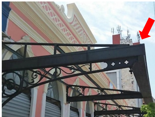
Figura 11: Vista lateral após instalação da calha. Fonte: Acervo próprio.
