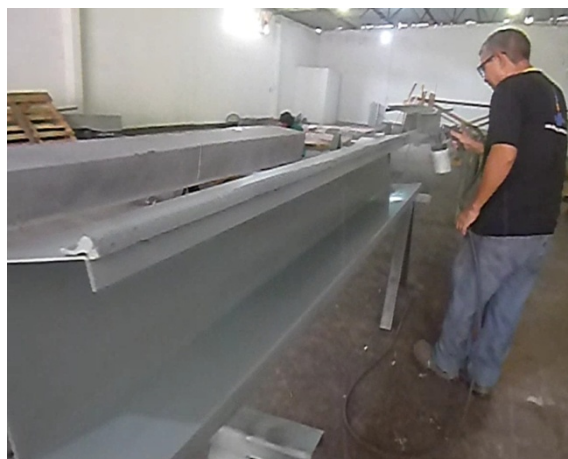
Figura 9: Aplicação da camada anticorrosiva. Fonte: Acervo próprio.
