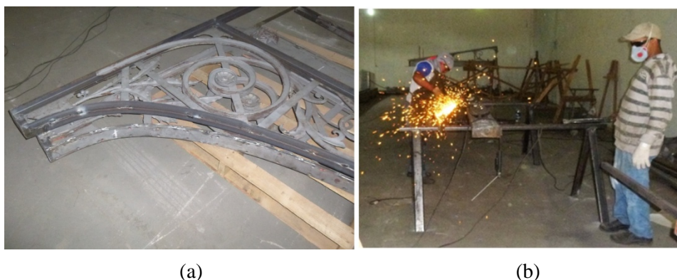
Figura 7: Tesoura após substituição das peças (a) e soldagem das peças novas (b). Fonte: Acervo próprio.
