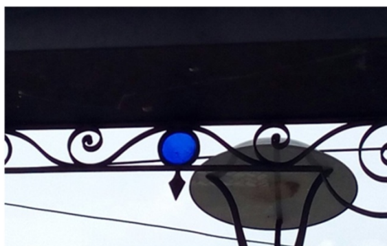
Figura 13: Lambrequins e vitrôs após instalados. Fonte: Acervo próprio.
