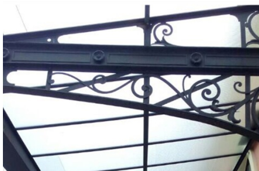
Figura 12: Terças centrais e cobertura de vidro. Fonte: Acervo próprio.
