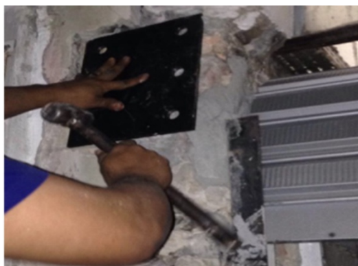
Figura 10: Fixação de chapas metálicas. Fonte: Acervo próprio.
