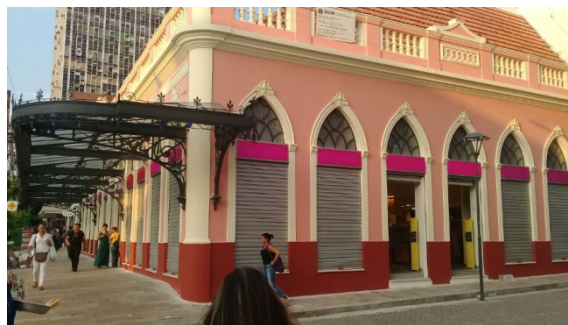
Figura 15: Fachada do imóvel após restauração. Fonte: Acervo próprio.
