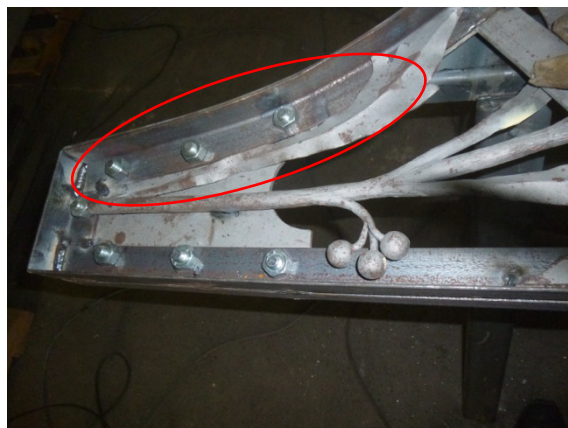
Figura 8: Detalhe dos parafusos sextavados. Fonte: Acervo próprio.
