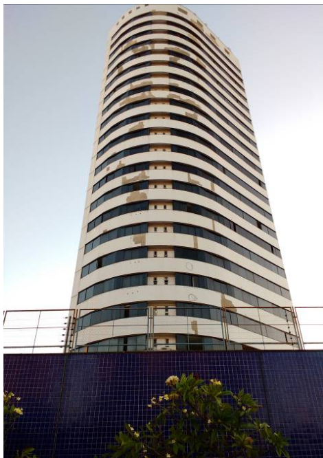
Figura 1: Fachada 1 Fonte: Autor, 2017
