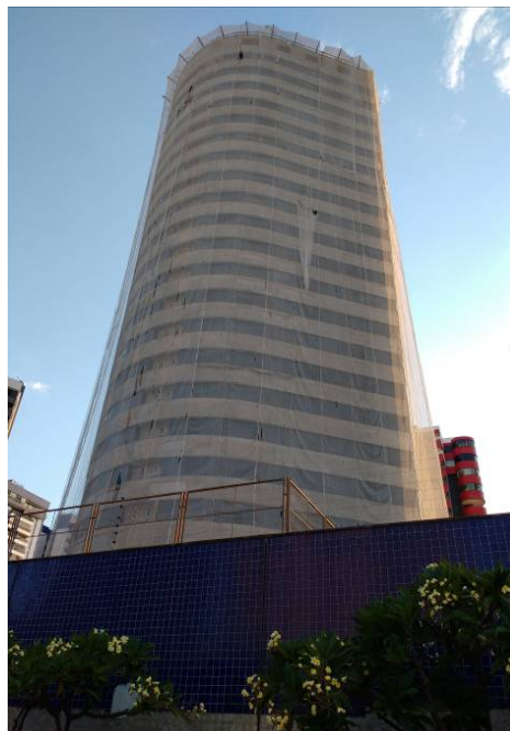
Figura 2: Fachada 1 Fonte: Autor, 2017
