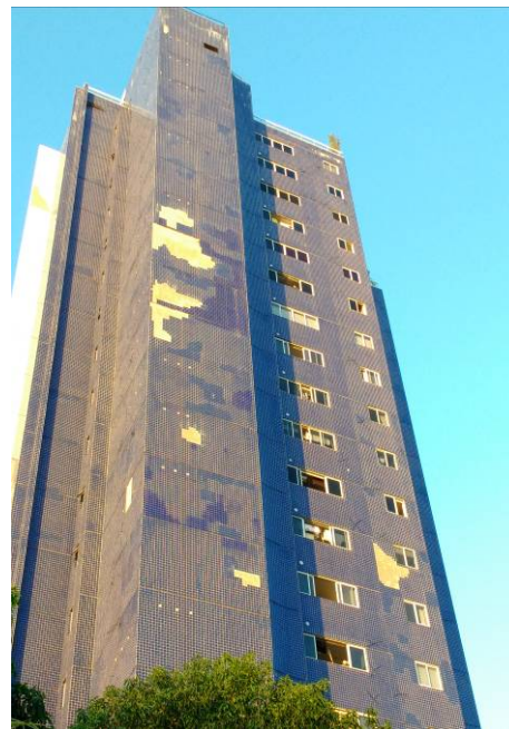
Figura 4: Fachada 1 Fonte: Autor, 2017
