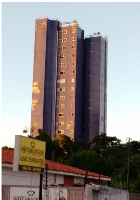
Figura 3: Fachada 1 Fonte: Autor, 2017
