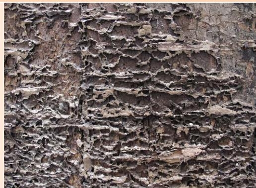
**Figura 2:** Ataque de insetos xilófagos, parede da Casa de Câmara e Cadeia de Itapemirim
