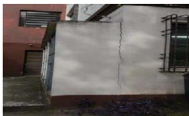
Figura 4 - Fissura na união de elementos novos à construção antiga
