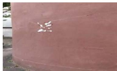
Figura 5 - Fissura decorrente de problemas estruturais
