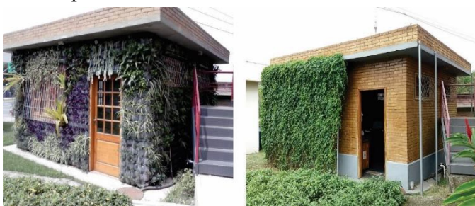
Figura 13: Antes e Depois do sistema de fachadas naturadas – do Módulo Fonte: IVIG
