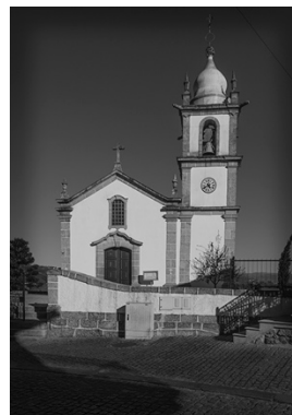
Fig. 3: Alçado principal da Igreja de Ataíde. Imagem do autor.
