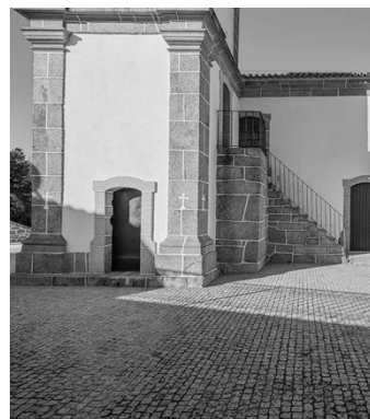
Fig. 6: Alçado lateral direito da Igreja de Ataíde, com a escada de acesso à torre sineira, recente. Imagem do autor.
