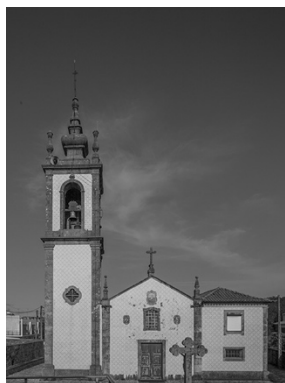
Fig. 4: Alçado principal da Igreja de Gilmonde, antes das obras. Imagem do autor.
