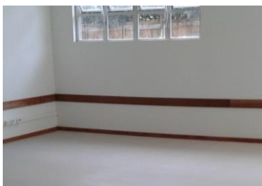
Figura 7: Referência de aplicação de rodameio (14 cm de espessura) [Fonte: Antunes et al. , (3)].
