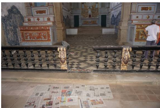
Figura 13: Grade da capela-mor danificada, com restos de materiais de obra. Sujeira de obra em todo o ambiente.
