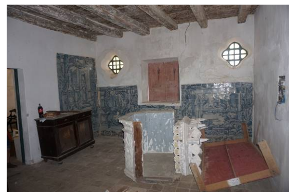
Figuras 8 e 9: Materiais de obra e bens integrados abandonados pelo chão, danificando-os ainda mais. Ausência de azulejos em um dos painéis.
