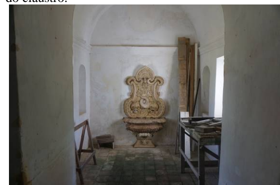
Figuras 6 e 7: Lavabos juntos com materiais de construção, correndo risco de maiores danos. Reparar madeiras apoiadas na parede, que podem tombar e danificar (quebrar) os lavabos.
