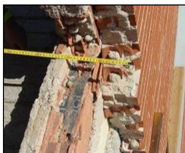
Figura 7: Apoyo sobre lámina impermeable.
