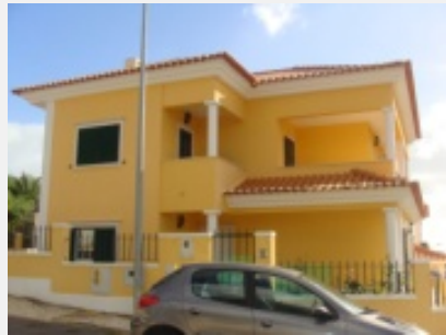
Sem degradação visível
