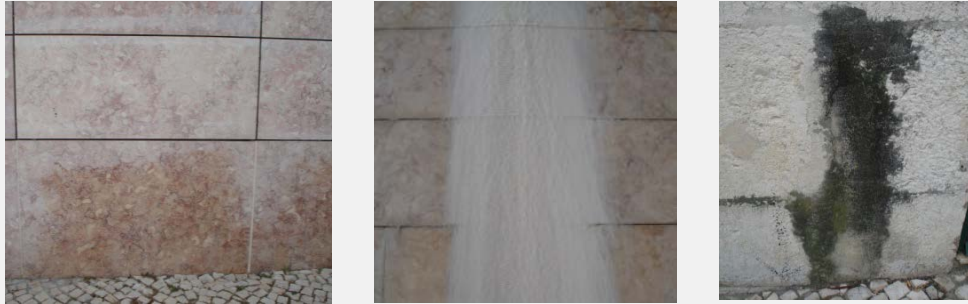
Anomalias visuais (da esquerda para a direita): eflorescências, manchas localizadas (humidade ascensional), vegetação parasitária, colonização biológica
