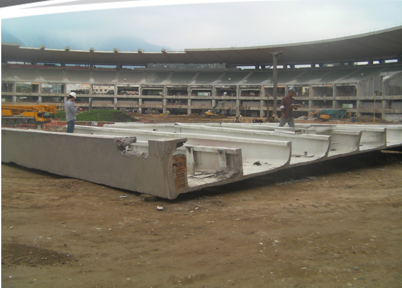
Segmento de laje de cobertura entre os eixos 48 e 49.
