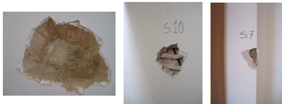
Figura 21 – Parede exterior de alvenaria de pedra e parede interior divisória de tabique e alvenaria de tijolo.
