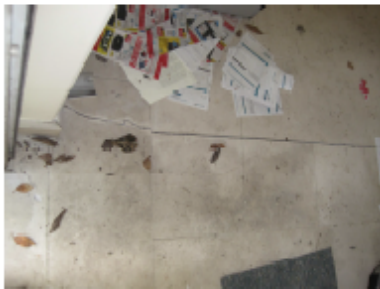
Figura 39 – Fissuras identificadas nos compartimentos C-1.01 e C0.08, respetivamente.
