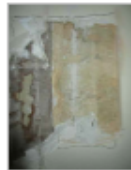
F.4 Sondagem S_51 no compartimento C-1.09 possibilita a visualização da parede de alvenaria de calcário e forra de aglomerado de madeira com linhaça e gesso.
