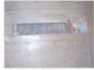
F.07 Possibilita a visualização do piso no compartimento C2.05 na sondagem Sond.1(1)-17 com a Resistograph com sondagem 5, 32 renovação de peça de madeira com 3cm de espessura.
