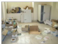
F.9 No compartimento C-1.04 possibilita a visualização do piso e material de calcário.
