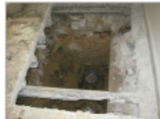
F.2 Sondagem S_48 no compartimento C-1.01 possibilita a visualização da laje aligeirada de piso térreo e fundações da parede de alvenaria de calcário.
