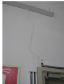
Figura 39 – Fissuras identificadas nos compartimentos C-1.01 e C0.08, respetivamente.
