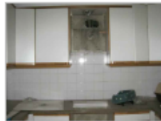
F.8 No compartimento C-1.06 possibilita a visualização da parede de alvenaria de calcário e tubagens de ventilação.
