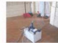
F.04 Possibilita a visualização do piso no compartimento C2.01 na sondagem Sond.1(1)-12.
