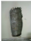
F.5 Sondagem S_52 no compartimento C-1.12 possibilita a visualização da parede de alvenaria de calcário e forra com placas de gesso.
