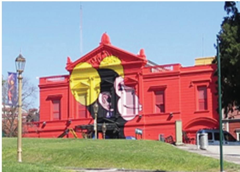
Figura 2 – (b) edificação em Buenos Aires, na Argentina, com linguagem arquitetônica neoclássica e intervenção cromática contemporânea voltada ao uso.
