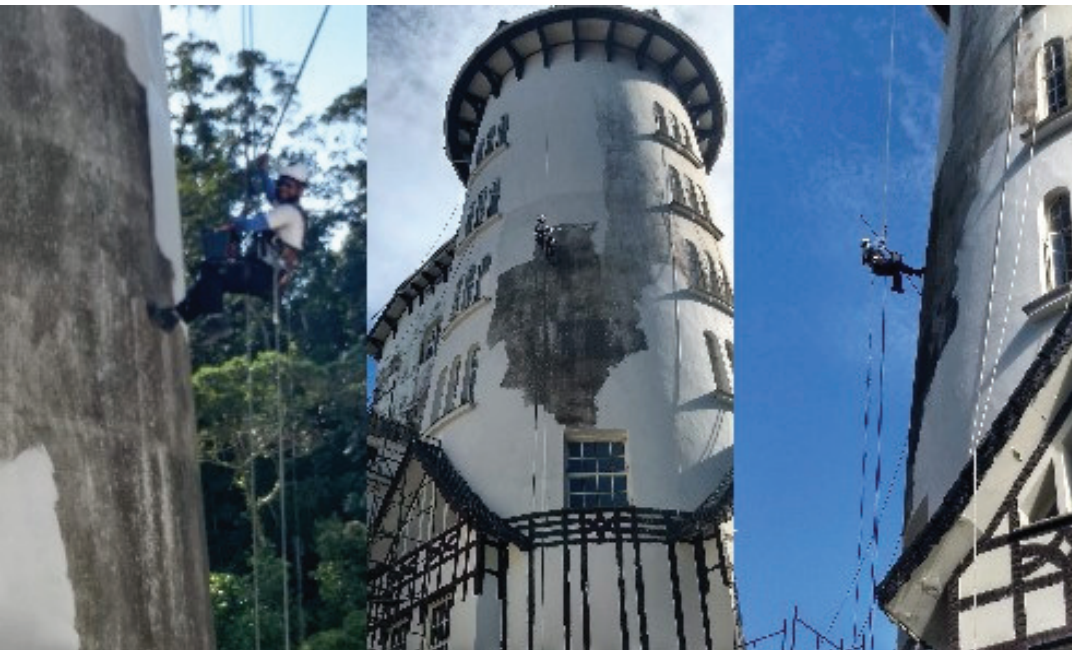
Figura 3 – Recuperação da Torre Fonte: Autores(2019)
