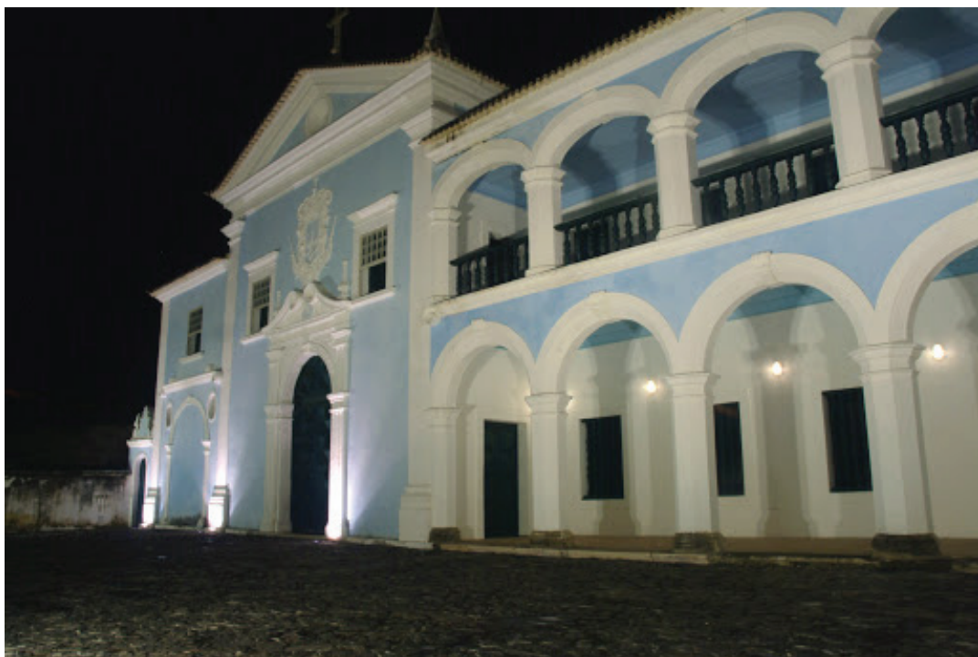
Figura 4 – Convento do Carmo antes da última restauração, na cidade de Cachoeira, Bahia Fonte: Google Imagens
