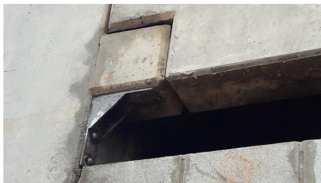
Figura 5: Chapa metálica para reforço do console do pilar (Fonte: Próprio Autor)
