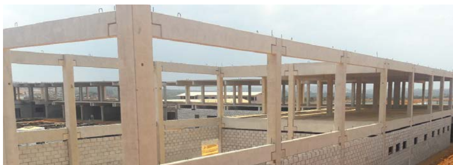
Figura 3: Estrutura com console dos pilares na edificação (Fonte: Próprio Autor)
