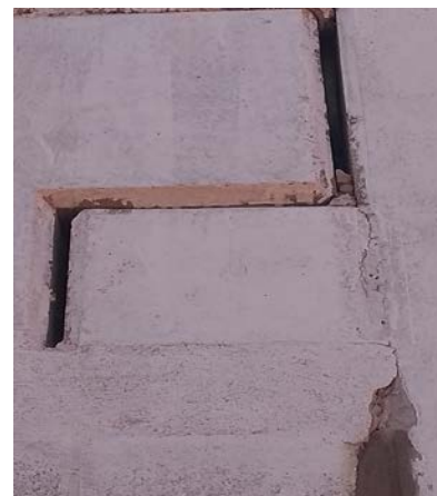
Figura 4: Fissura no console do pilar (Fonte: Próprio Autor)
